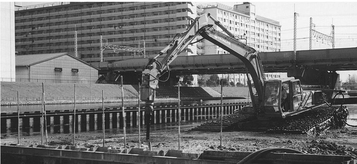
b) LVM工法(長尺垂直式施工法)(図5-18)
