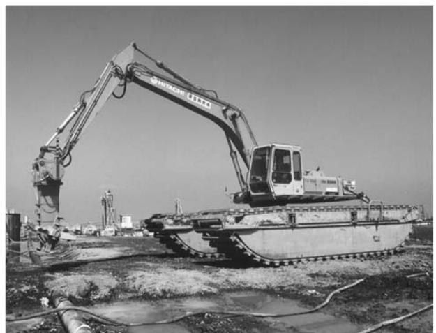
d) ARM工法(ロータリー式施工法)(図5-22)
