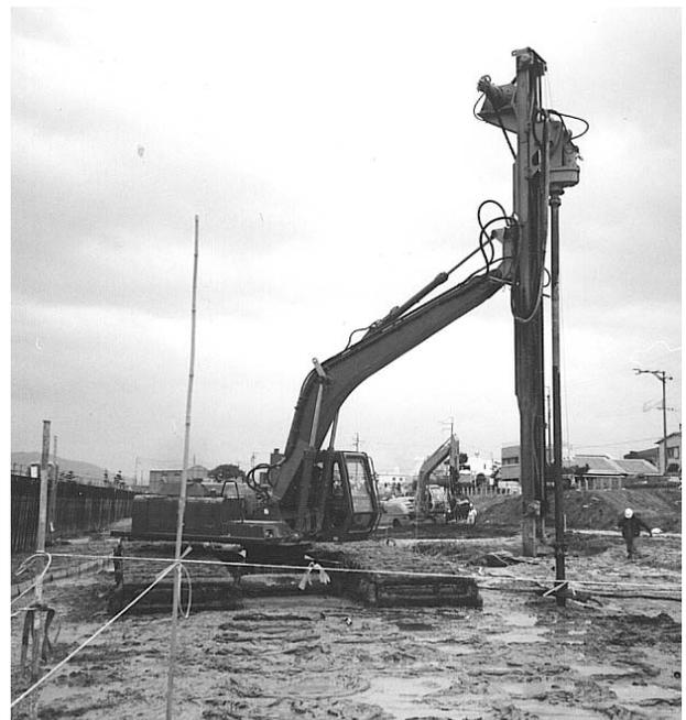
c) RM工法(ロータリー式施工法)(図5-20)
